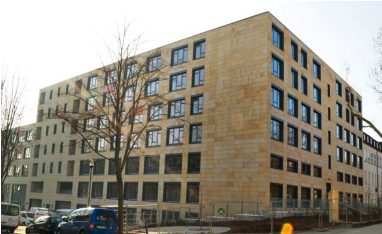
Foto: Der fertige 2. Bauabschnitt des Diakonissen-Krankenhauses Ecke Kirchweg /Goethestraße, 2015
