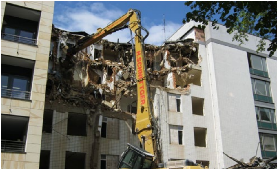
Foto: Abriss des alten Bettenhauses am Kirchweg 2012.
